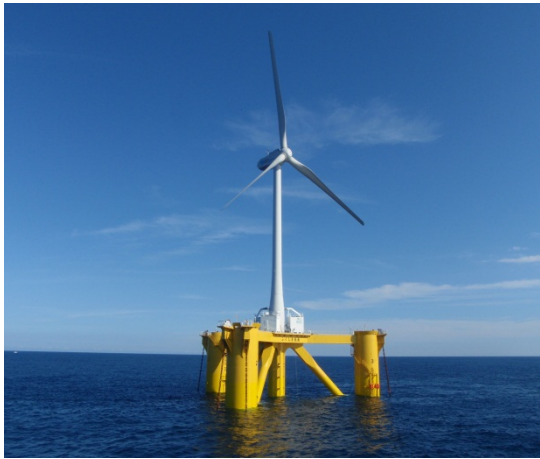
2MW ダウンウィンド型浮体式洋上発電設備 「ふくしま未来」(浮体形式：コンパクトセミサブ)
