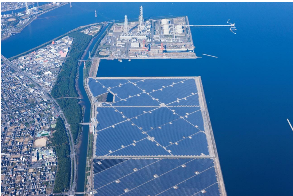
【大分ソーラーパワー 空撮写真】
