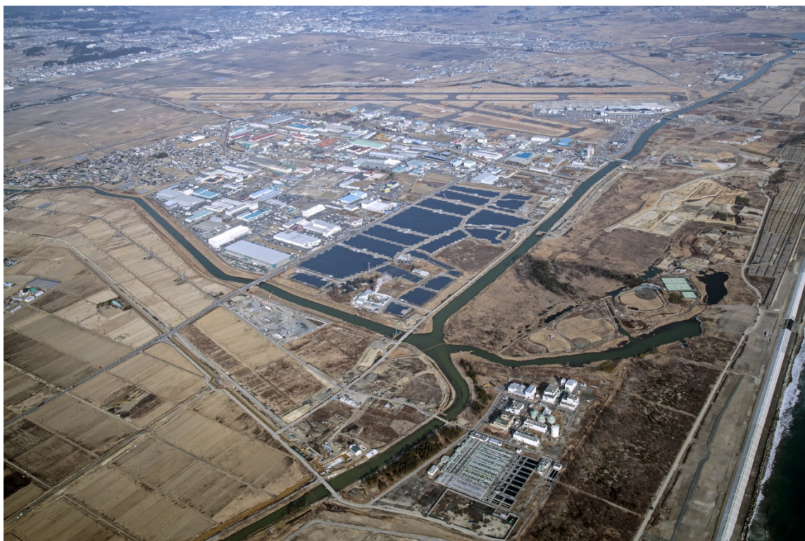
【いわぬま臨空メガソーラー発電所／航空写真】
